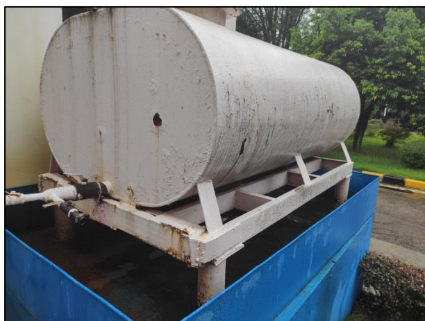
冷干粉针车间西北面碱罐
