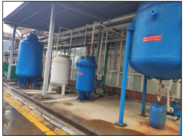
API-II 原料药车间北面母液中转罐
