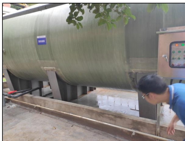
污水处理站东面聚铁储罐
